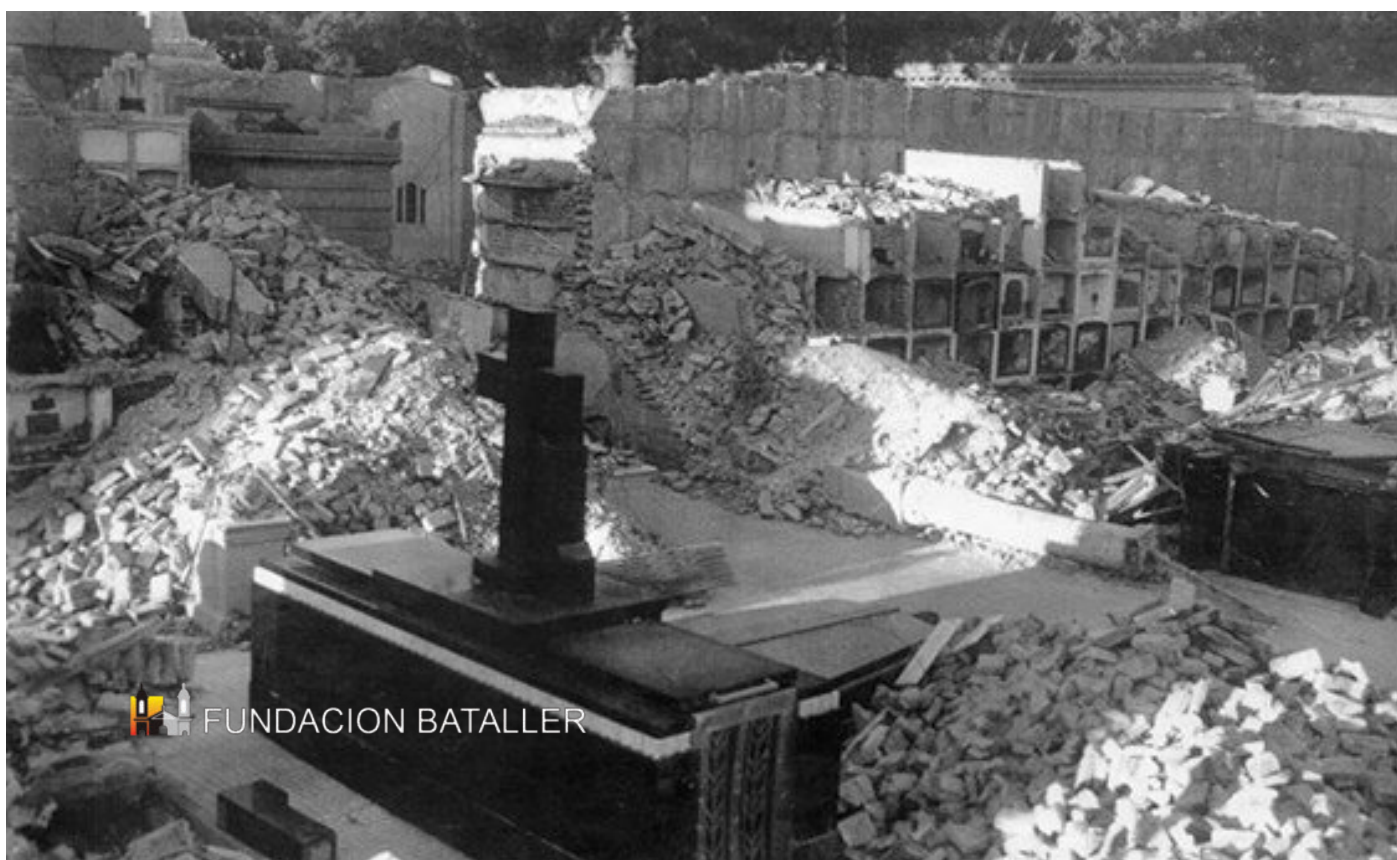
La foto muestra los daños que produjo en el cementerio capitalino el terremoto de 1944
