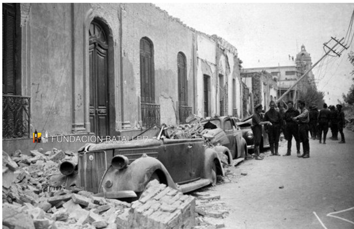
Calle Mendoza. A las horas de producido el terremoto, los miembros del Ejército llegaron para colaborar con la remoción de escombros y retirar los autos destruidos. Al fondo se ve las torres de la Iglesia Catedral.
