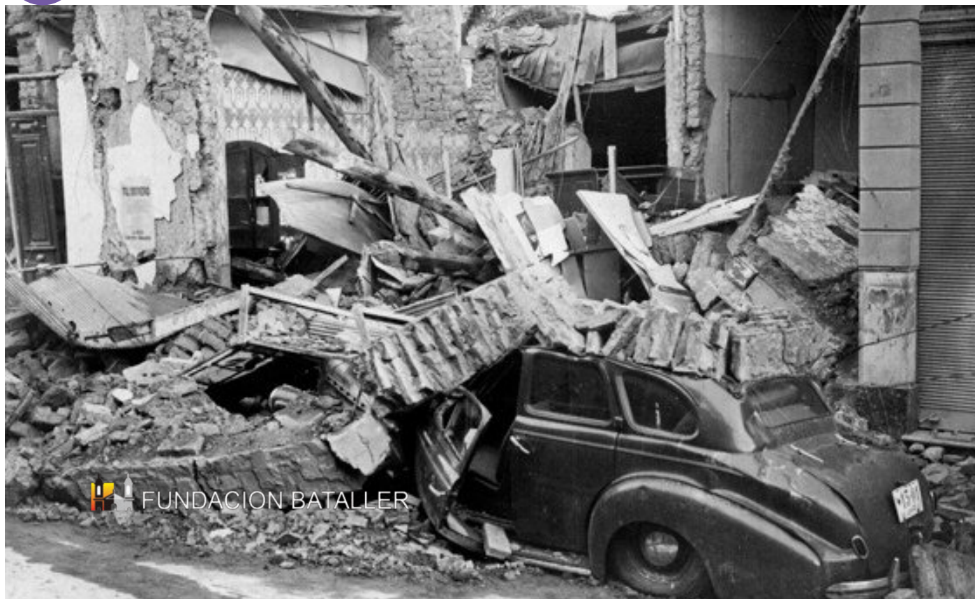
La foto muestra los daños en la casa de un médico, según muestra la chapa patente del auto. Al lado, el local de la una talabartería. Se aprecia el espesor de las paredes de adobe.
