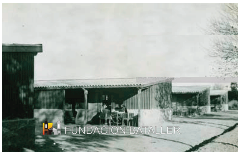
Vista de un grupo de viviendas construidas con chapas "onda-lit" del Barrio Dr. Bardiani.
