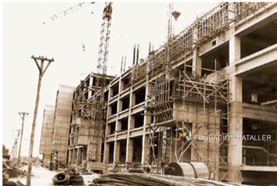
La obra, el andamiaje y las grúas abandonadas. Así estuvo por más de 10.000 días. El 30 de abril de 2009 se terminó.
