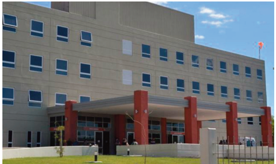
El Hospital Rawson es una verdadera joya tanto en su arquitectura como en su equipamiento. ¿Se logrará hacer que todos los servicios funcionen las 24 horas al día o al menos 16?
