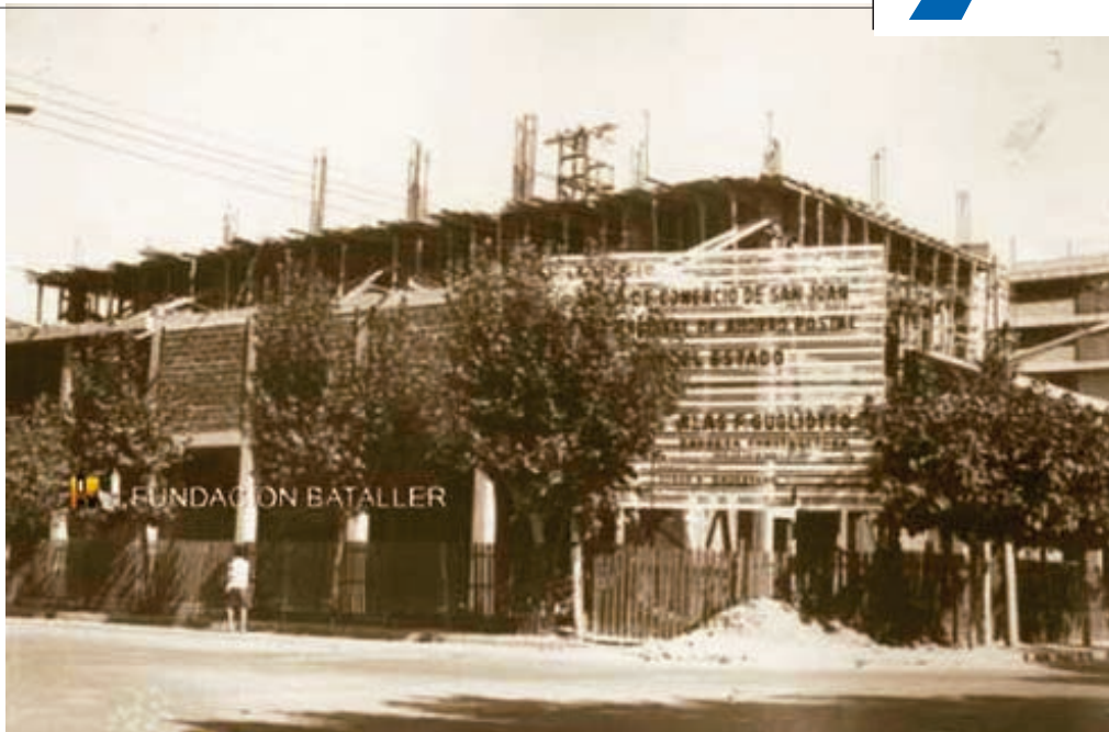
1964 - Esta fotografía muestra, en avanzada etapa de construcción, la obra del edificio de la Bolsa de Comercio, que albergaría también a la Federación Económica, la Caja Nacional de Ahorro y Seguro y Gas del Estado. Ubicado en calle General Acha, parte de la Avenida José Ignacio de la Roza y Mitre, su constructor fue ALAS de F. Guglioto y el responsable técnico, César Savastano. El edificio estaría terminado en 1965 y forma parte de las obras edilicias más destacadas de la reconstrucción de San Juan.
