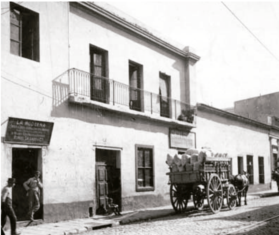
La jabonería de Vieytes no está en pie y el edificio de departamentos que fue erigido en el lugar, cayó bajo la piqueta y a la parcela le pasó por encima la avenida 9 de Julio
