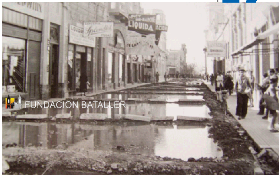
La foto fue tomada en 1935 y nos muestra la calle Rivadavia en el tramo comprendido entre Tucumán y General Acha en el tiempo en que el pavimento llegaba a la ciudad. Casi 500 cuadras con sus correspondientes cordones, desagües pluviales y cloacas se pavimentaron durante el gobierno de Juan Maurín y la intendencia de Silvio Baistrocchi. (Foto proporcionada por Alberto Zimmerman).
