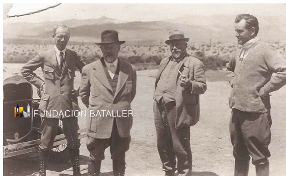
En las obras del Tren de las Nubes. De izquierda a derecha, el tercer hombre que aparece en esta fotografía es Kristoffe Lund, que trabajó en la construcción del tren durante la década del veinte.
